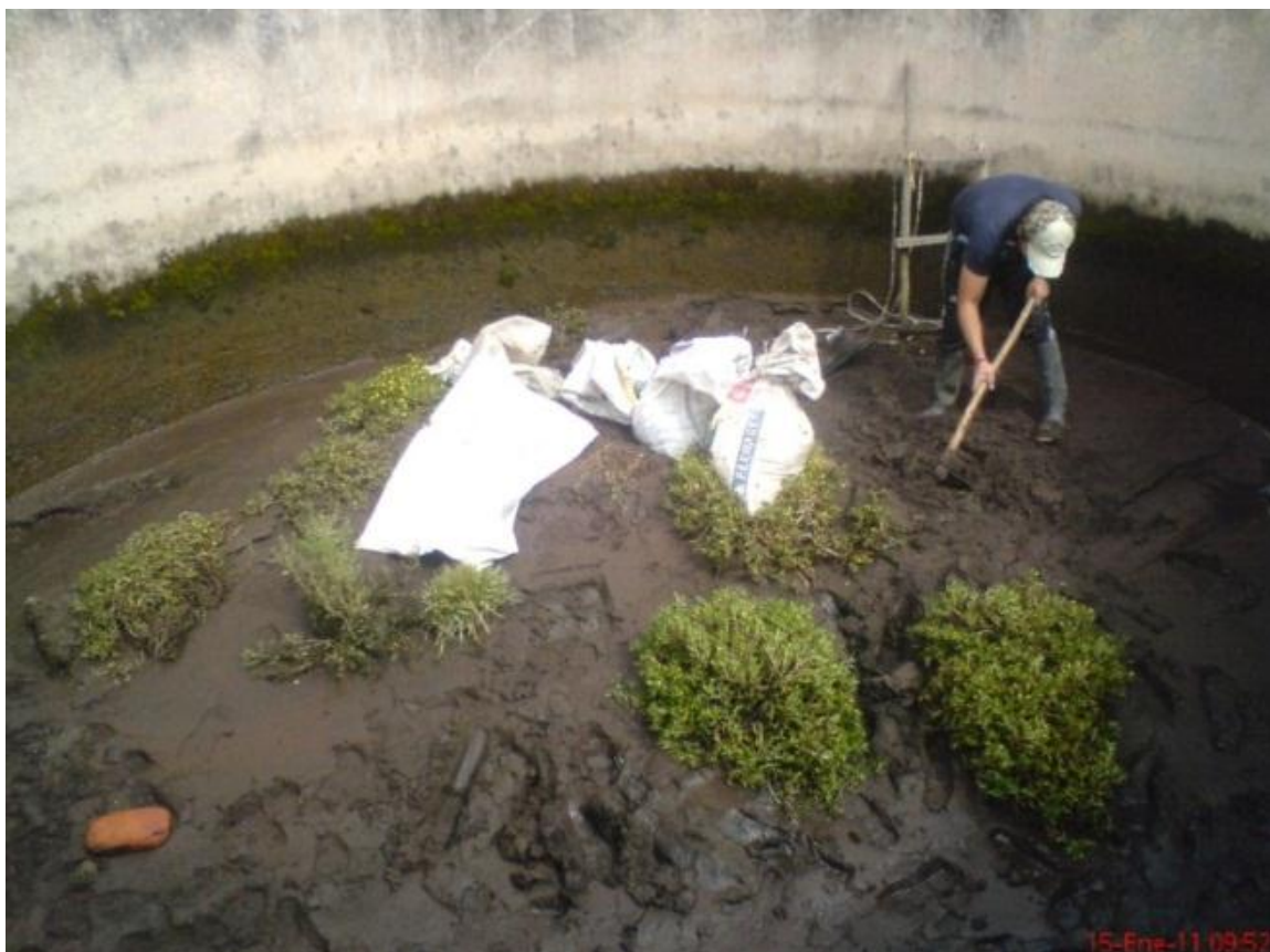
Imagen 11: Recolección de los lodos residuales
