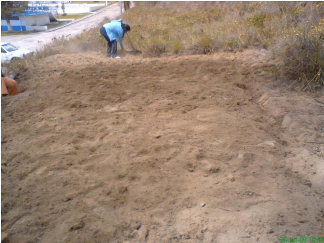
Imagen 9: Preparación del terreno
