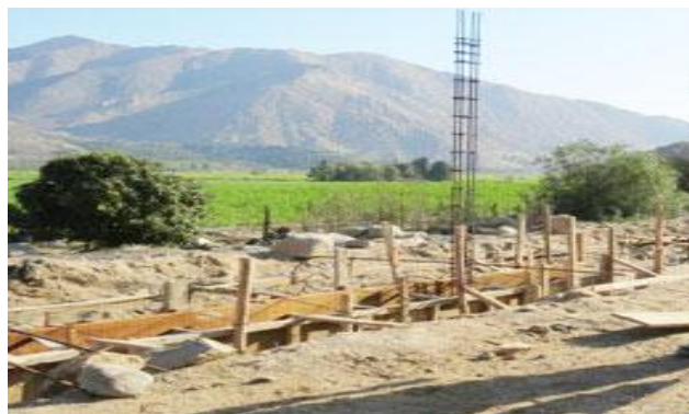
Ilustración 1. Construcción del Centro de Acopio Elaborado por: Estefanía
