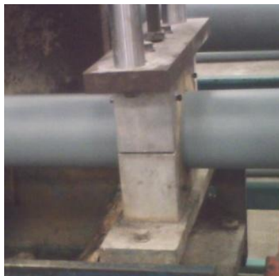
FIGURA 2.13 SUJECIÓN DE LA TUBERÍA PARA EVITAR DESLIZAMIENTO (FUENTE: ELABORADO POR AUTOR)
