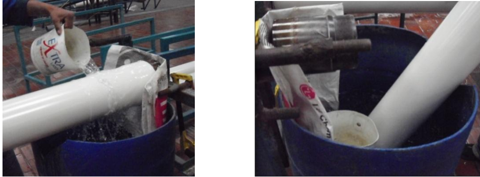
FIGURA 2.11 ENFRIAMIENTO DE LA TUBERÍA (FUENTE: ELABORADO POR AUTOR)
