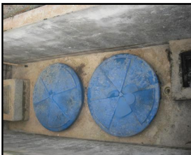
Figura N° 4. Tratamiento Primario(Trampas de grasa) y Lugar de Muestreo Fuente: CARNIDEM
