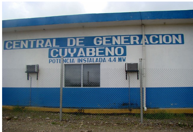
Figura 4.15. Cuarto de Control
