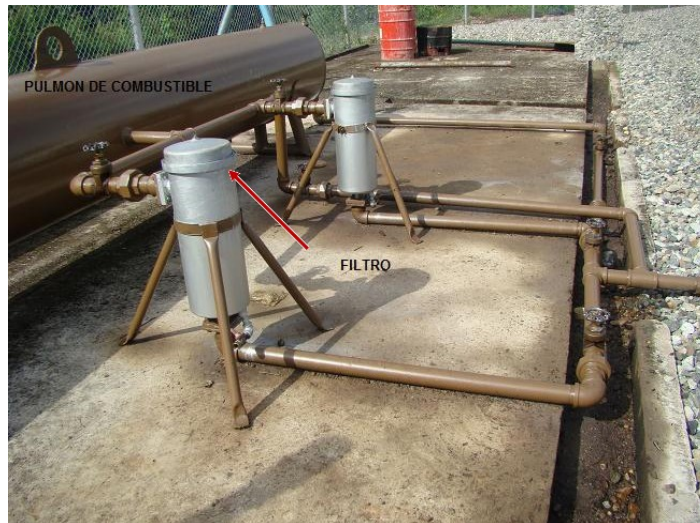
Figura 4.8. Purificación del Combustible
