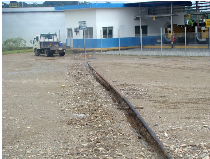
Figura 5.36. Tendido de Tubería
