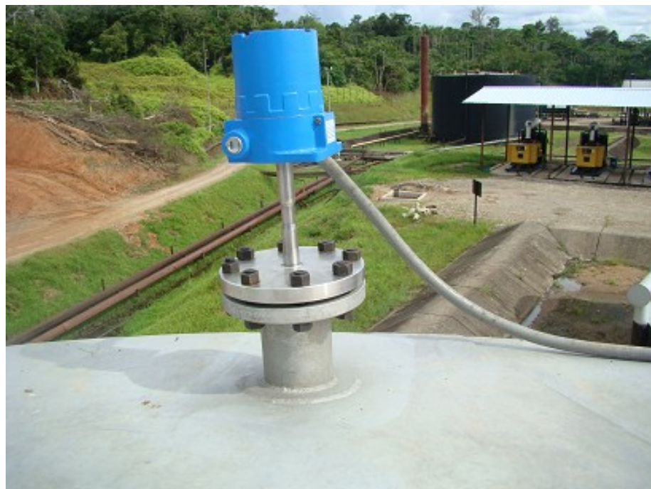
Figura 5.50. Montaje Conexiones medidor de nivel
