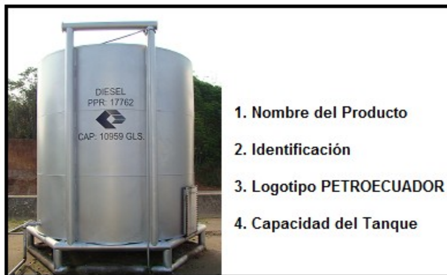
Figura 2.17. Identificación de Tanques
