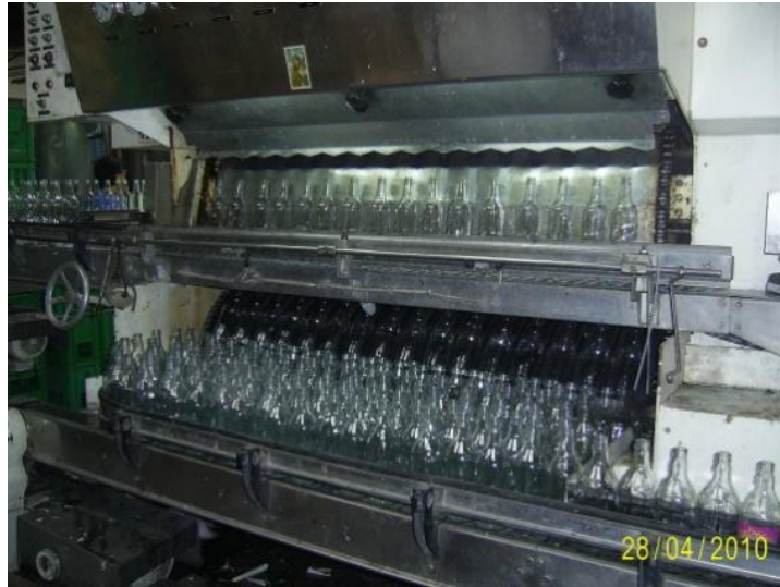
Imagen 3. Lavadora de botellas cargada con 16 hileras de botellas y en proceso de lavado, en el cual se utiliza agua residual pura
