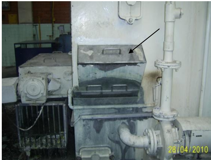
Imagen 5. Compartimento por el cual se introduce la Lejía o Sosa Cáustica
