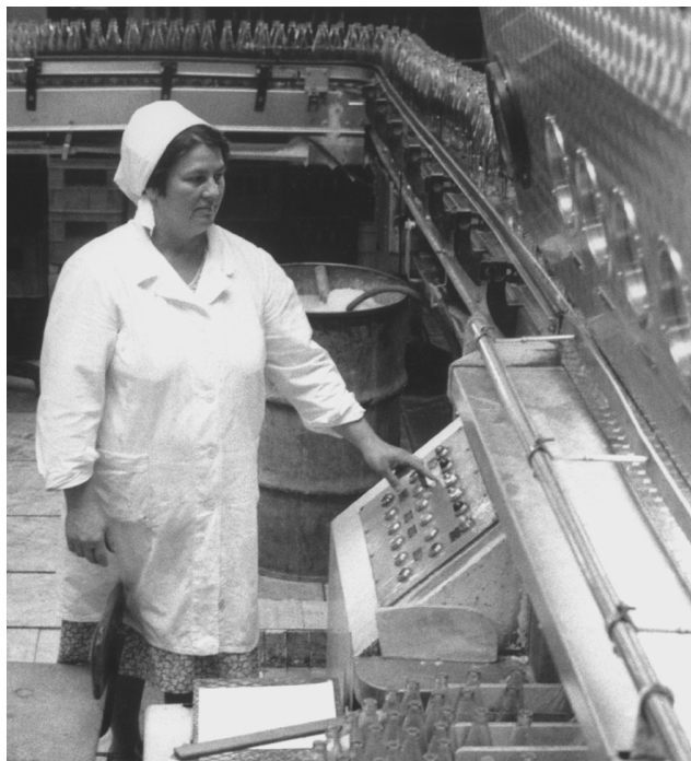
Figura 65.1 • Panel de control de una planta automática de bebidas refrescantes en Novosibirsk, Rusia.
