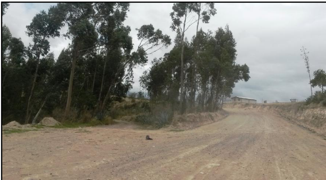
Ilustración 31: Tramo de la vía Chan – Tiobamba km 0+500 – km 1+000
