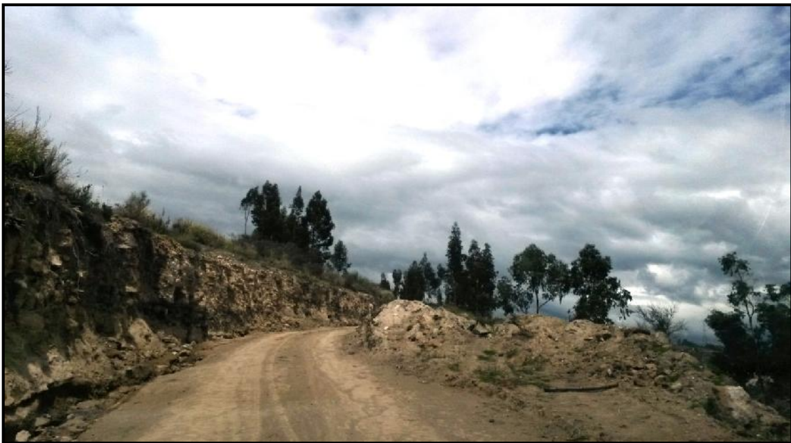
Ilustración 33: Tramo de la vía Chan – Tiobamba km 1+500 – km 2+000
