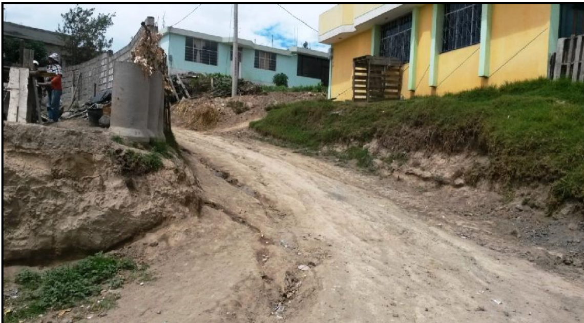
Ilustración 36: Tramo de la vía Chan – Tiobamba km 3+000 – km 3+500
