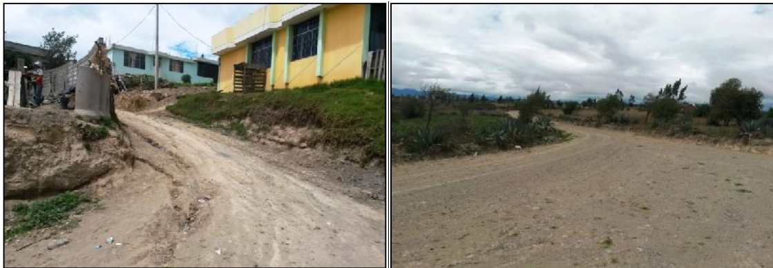
Curvas en la vía Chan – Tiobamba
