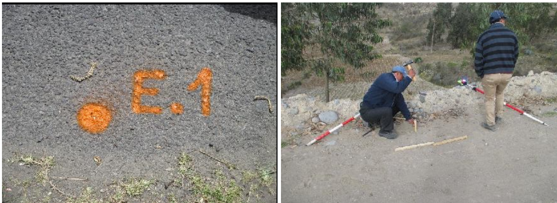
Ubicación de las estaciones y puntos de referencia del levantamiento topográfico
