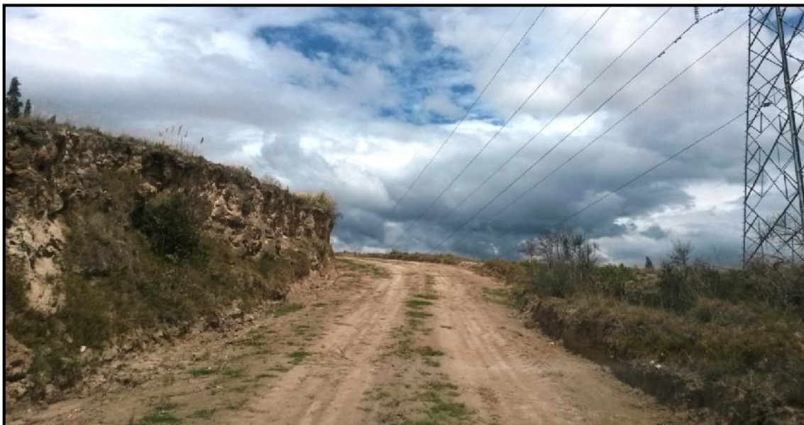
Ilustración 34: Tramo de la vía Chan – Tiobamba km 2+000 – km 2+500
