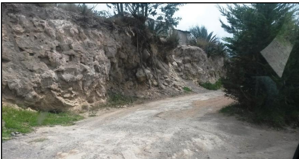
Ilustración 35: Tramo de la vía Chan – Tiobamba km 2+500 – km 3+000
