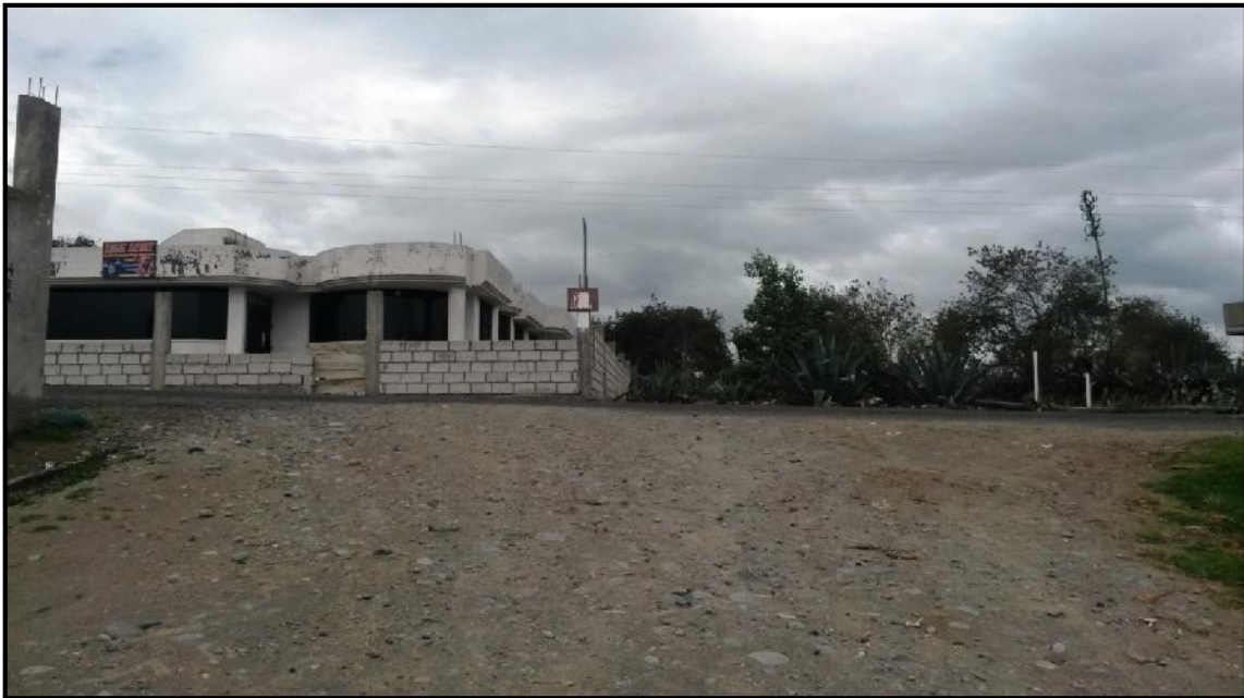
Ilustración 30: Tramo de la vía Chan – Tiobamba km 0+000 – km 0+500
