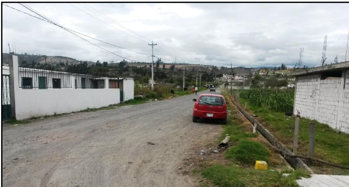
Ilustración 37: Tramo de la vía Chan – Tiobamba km 3+500 – km 4+000
