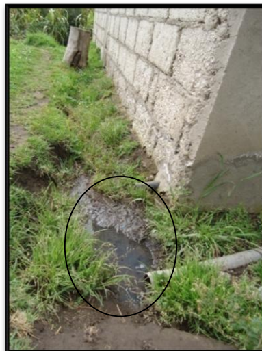
Foto N°4. Destino de las aguas de uso doméstico.
