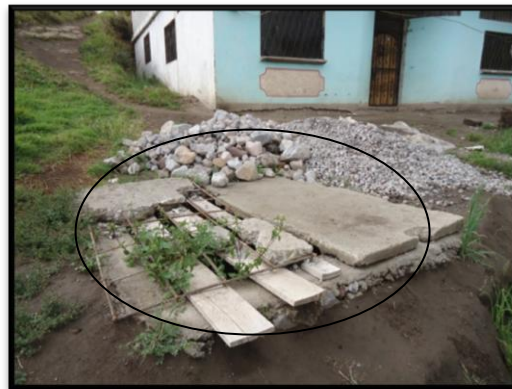
Foto N°3. Pozos sépticos que disponen los moradores del Caserío San Juan
