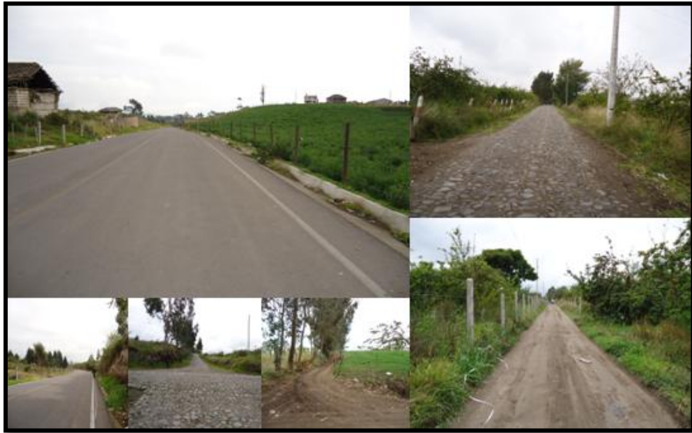
Foto N°14. Sistema Vial del Caserío San Juan
