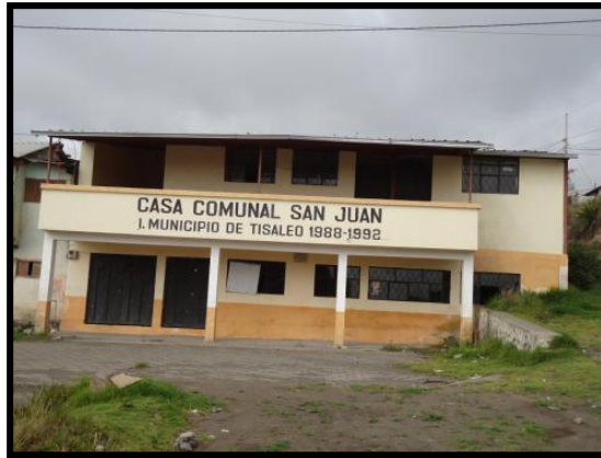
Foto N°12. Casa Comunal del Caserío San Juan.
