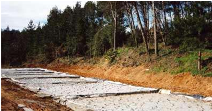
Construcción del humedal
