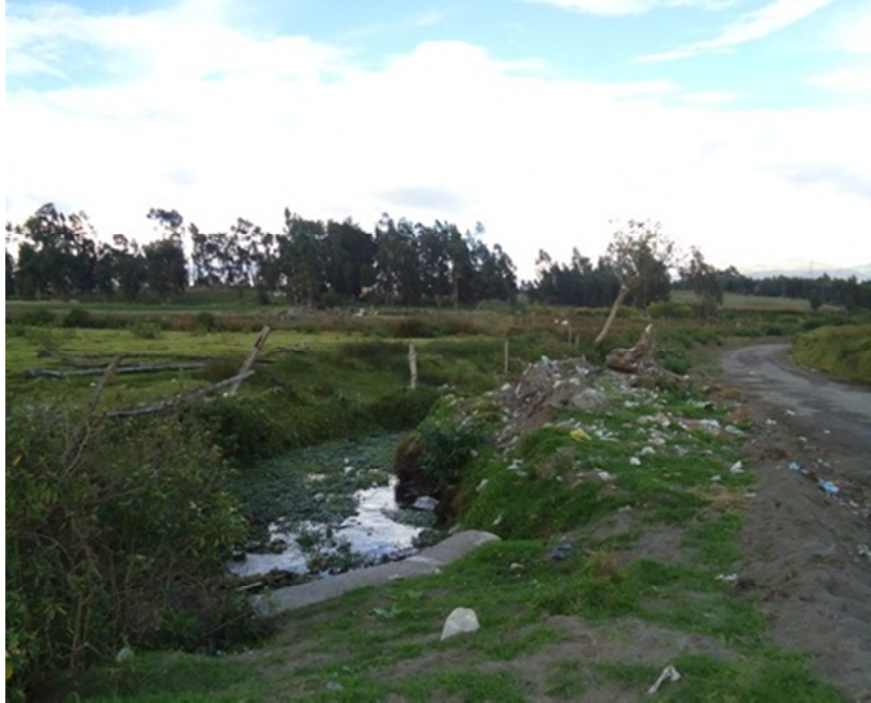
ACEQUIA DE LLEGADA DESDE LA PLANTA DE TRATAMIENTO.
