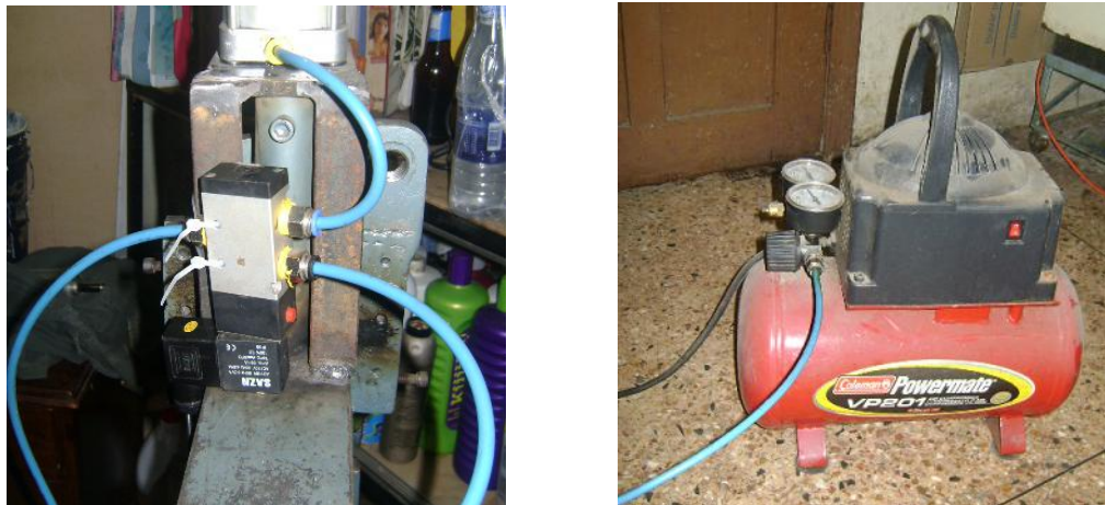
FIGURA 6.13 Acoplar y verificar electroválvula
