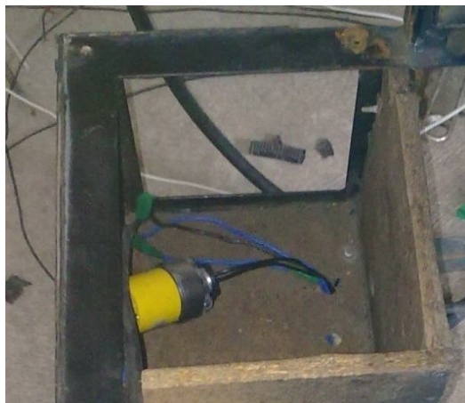
Figura 6.46. Cableado (fuente 24 VDC, regulable).
