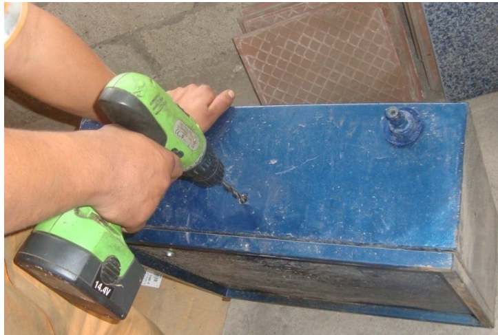
Figura 6.52. Perforación de la parte posterior del tanque almacenador.
