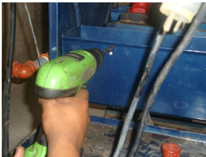
Figura 6.56. Perforado (tanque Decantador). Elaborado por: El investigador
