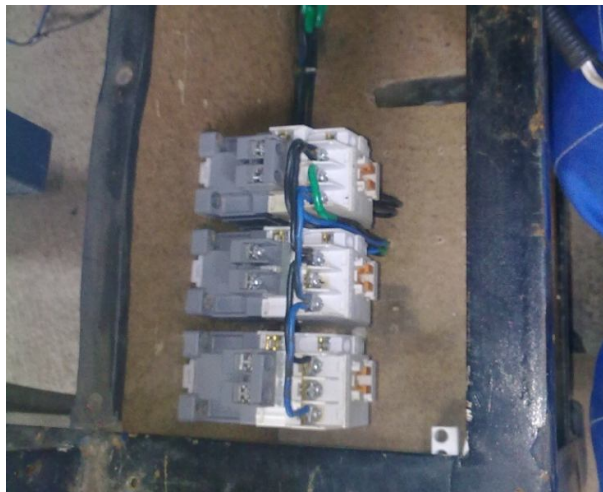
Figura 6.44. Empotramiento de los contactores GMC(D) - 12 , e inicio del cableado.
