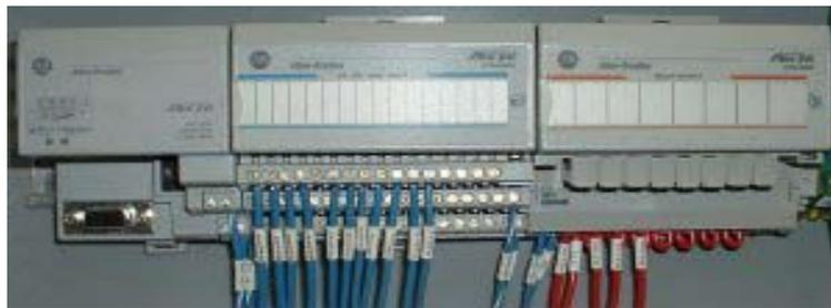
**Figura 2.7** Salidas y entrada del Plc
