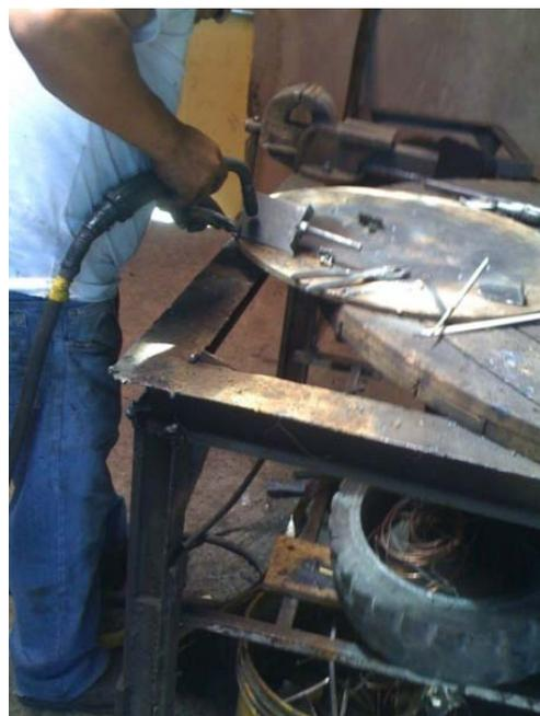
*Figura 6.18: Soldadura de los ejes a la compuerta
