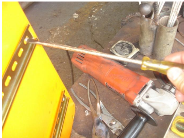
Figura 6.12 Ajuste del riel Din
