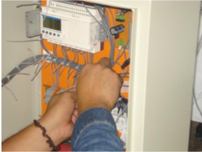
Figura 6.26 Conexión de las salidas
