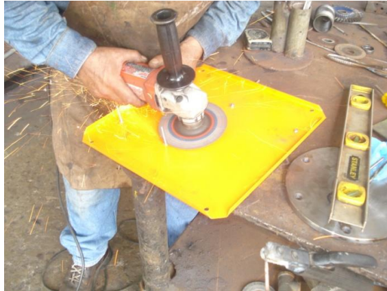
Figura 6.13 Corte del exceso de los tornillos de ajuste del riel din
