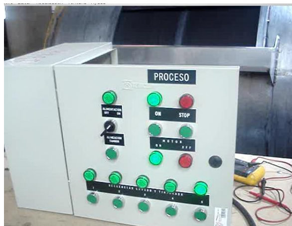
Figura 6.30 Instalación máquina lavadora horizontal de 60 kg.
