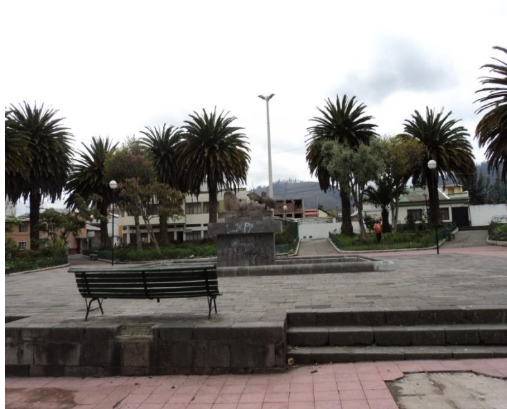
Fotografía 36 Piso y mobiliario en descuido total
