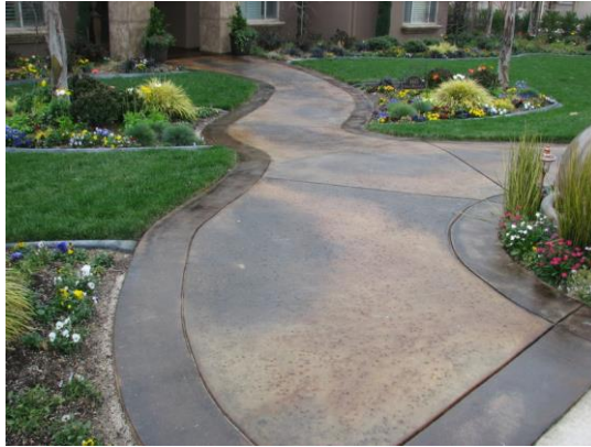
Fotografía 27 Pavimento de Concreto de color
