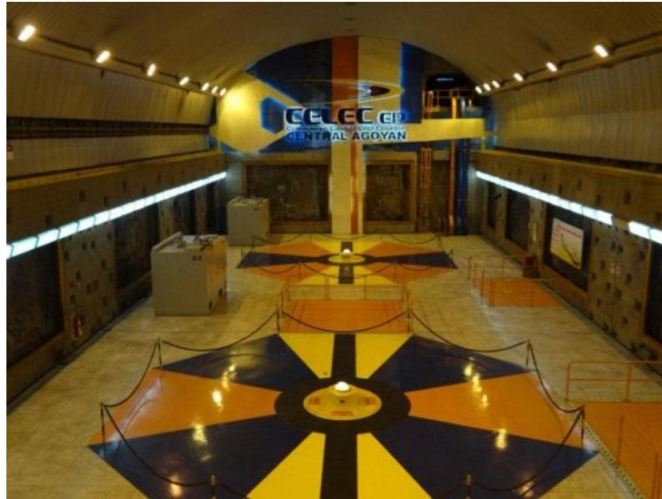
Figura 4.1. Central Hidroeléctrica Agoyán Fuente: CELEC EP – Hidroagoyán
