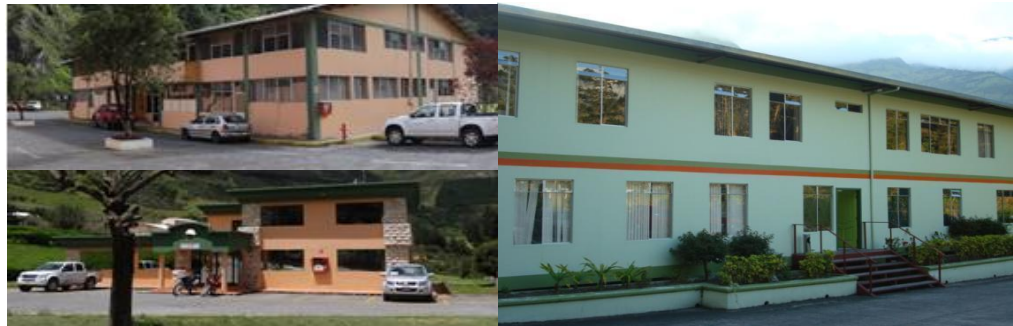
Figura 4.4. Oficinas Administrativas Fuente: CELEC EP – Hidroagoyán
