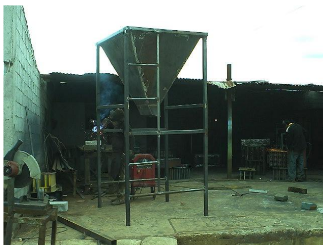
Fig. 6.57 Estructura de la Tolva
