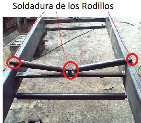
Fig. 6.62 Proceso de Soldadura de los Rodillos (Fuente: Egdo. Paul Quispe)
