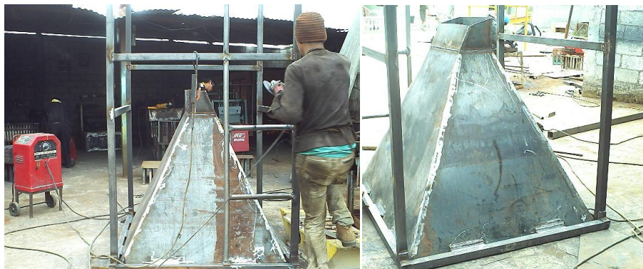
Fig. 6.55 Tolva Construída (Fuente: Egdo. Paul Quispe)
