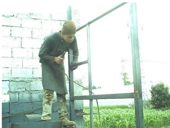
Fig. 6.56 Construcción de Escalera de la Tolva
