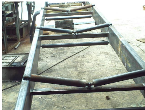
Fig. 6.52 Rodillos colocados en la Estructura (Fuente: Egdo. Paul Quispe)
