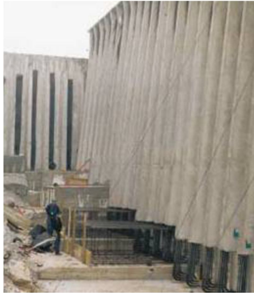
Fig.B.21.- Muros prefabricados
