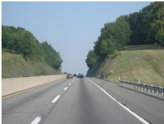
Fig.B.27.- Estabilización de taludes mediante vegetación
