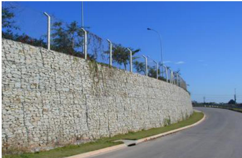
Fig.B.19.- Muros de gaviones
