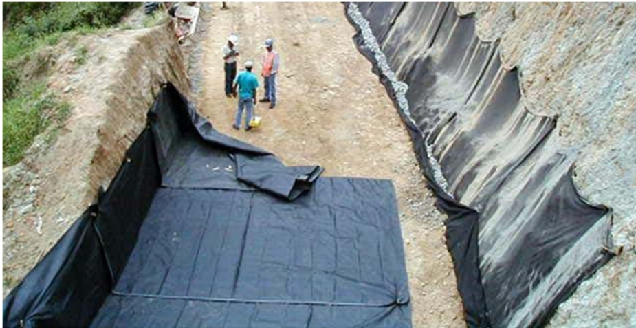
Fig.B.21.- Muros de tierra reforzada con geosinteticos
