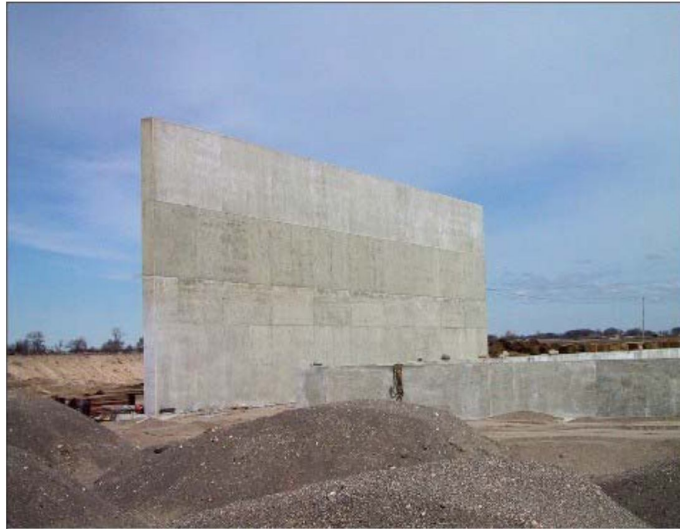
Fig.B.20.- Muros ménsula
