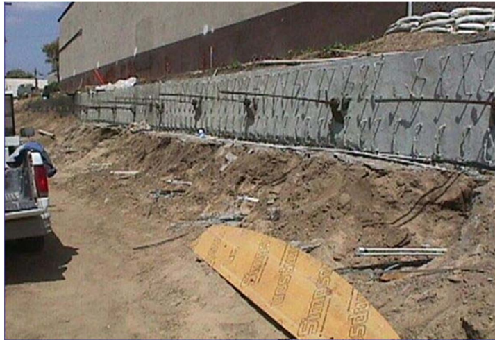
Fig.B.24.- Muros anclados
