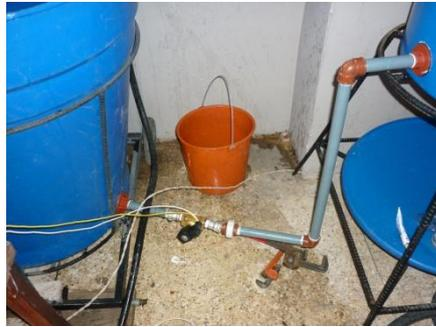
**Figura 6.3** Colocación de la electroválvula
