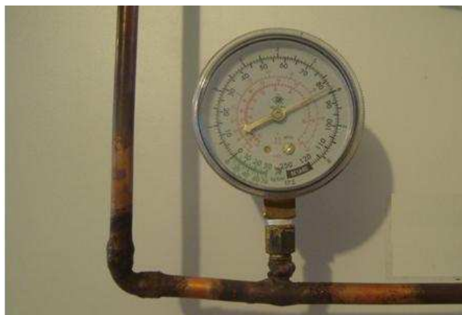
IMAGEN 6.13. Codo de 90° y manómetro soldados.
