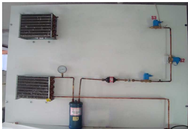
IMAGEN 6.25. Línea de alta, salida de solenoide 1-entrada de solenoide 3.
