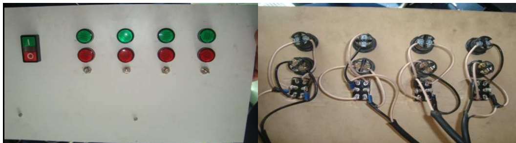
IMAGEN 6.17. Colocación de accesorios del tablero de control.
