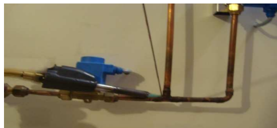
IMAGEN 6.27. Soldadura en la unión en T.
