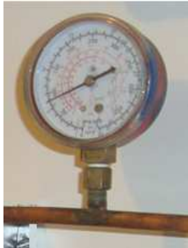
IMAGEN 6.12. Manómetro de alta soldado en la tubería de cobre.
