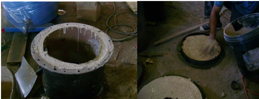
FIGURA 6-11: Colocación del cemento refractario
