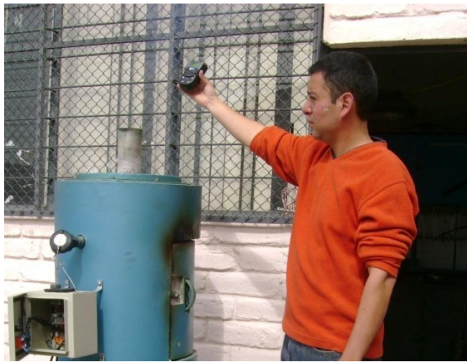
Figura 4-1: Medición monóxido de carbono.
