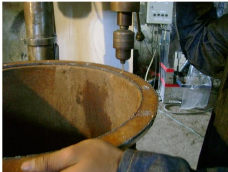
FIGURA 6-7: Colocación de bridas
