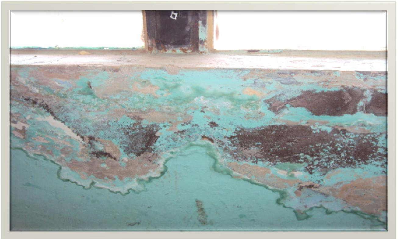
Paredes deterioradas por la humedad y falta de mantenimiento de lapintura.
