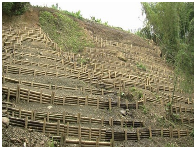
Figura 18: Barreras de filtros para sedimentos.
