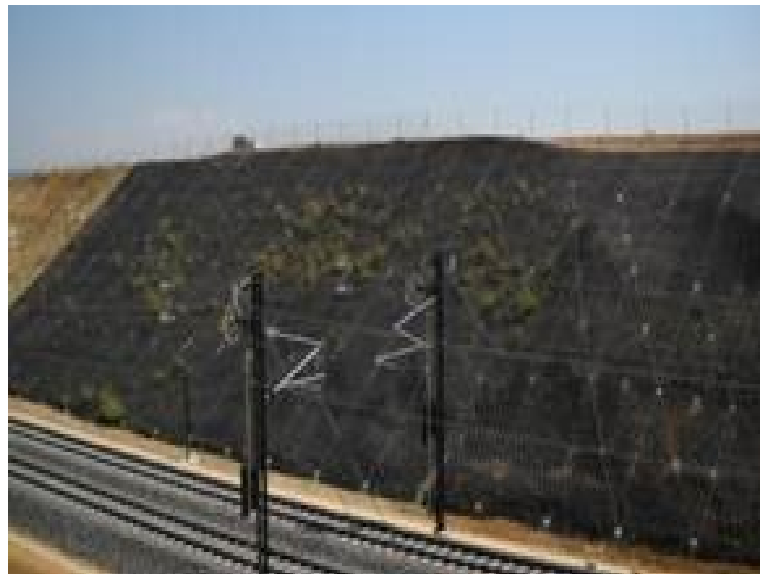
Figura 6: Colocación de plásticos de protección en laderas
