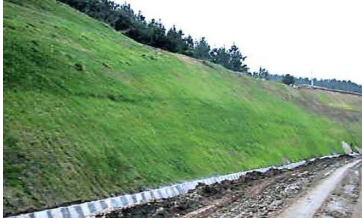
Figura 16: Vegetación colocada en talud estabilizado.
