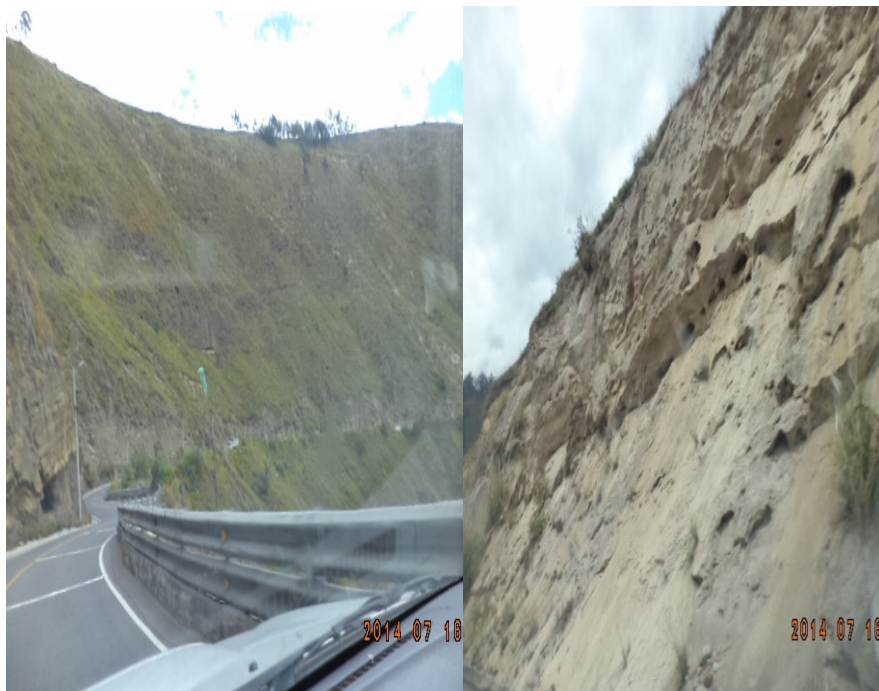
Foto 2: Vista panorámica del talud en estudio
