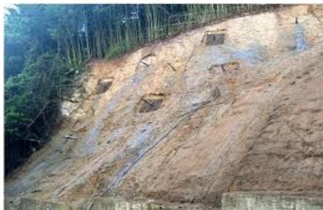
Figura 9: Anclajes con lechada o hidrosiembra
