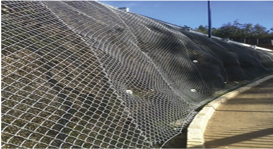
Figura 13: Barras de acero corrugado en corona y pie de talud.
