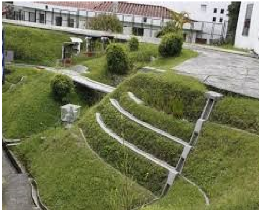
Gráfico 14: Sección lateral de canales de corona.
