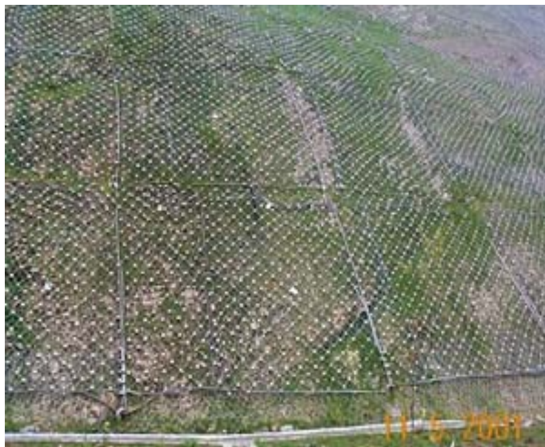
Figura 7: Colocación de mallas galvanizadas en taludes
