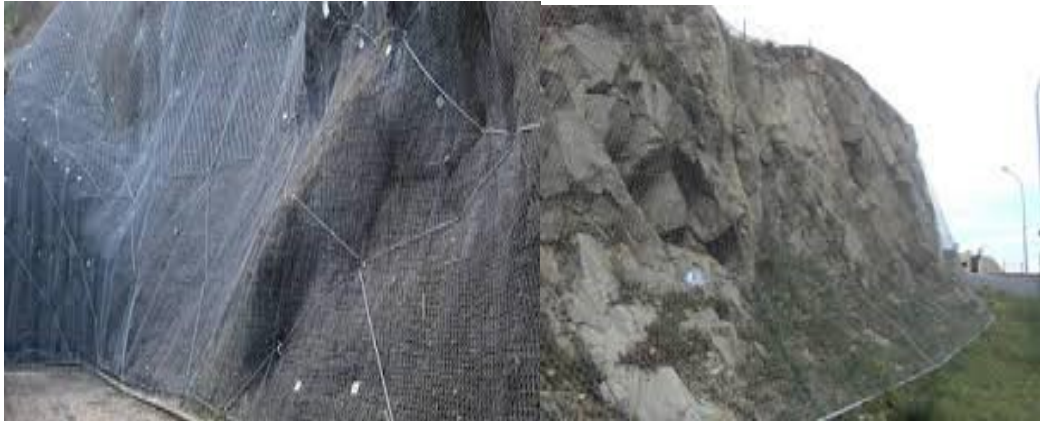
Figura 10: Ubicación de anclajes con mallas.
