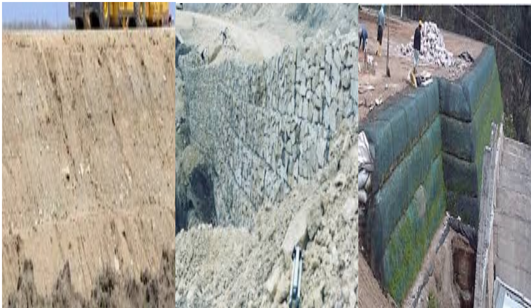
Figura 5: Terraplenes, pedraplenes e hidrosiembra
