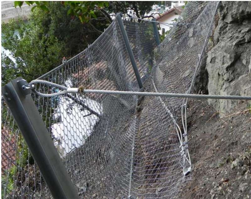
Figura 12: Redes de malla de acero corrugado.
