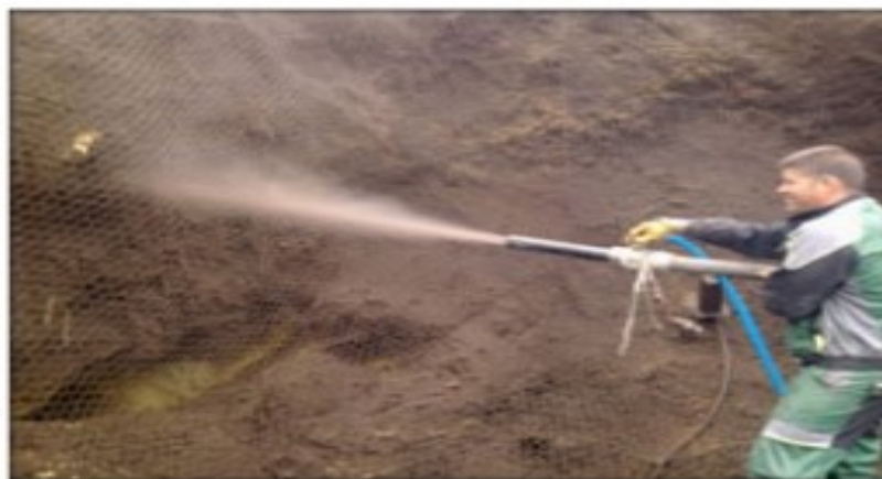
Figura 11: Inyección de manto ecológico en malla.
