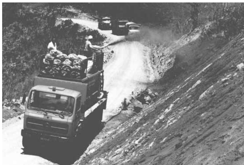
Figura 17: Inyección de semillas en taludes.
