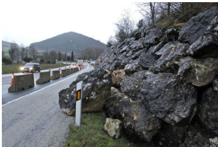
Figura 20: Muros de escolleras (Rocas).
