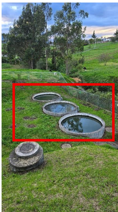
Fig. 34 Filtro Anaeróbico De Flujo Ascendente
