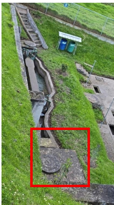
Fig. 29 Cámara de entrada
