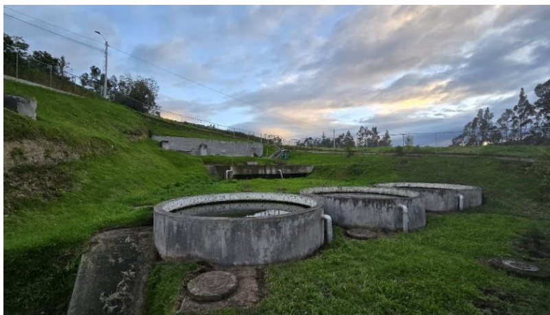
Fig. 27 Vista general de la Planta de Tratamiento de Aguas Residuales Callate
