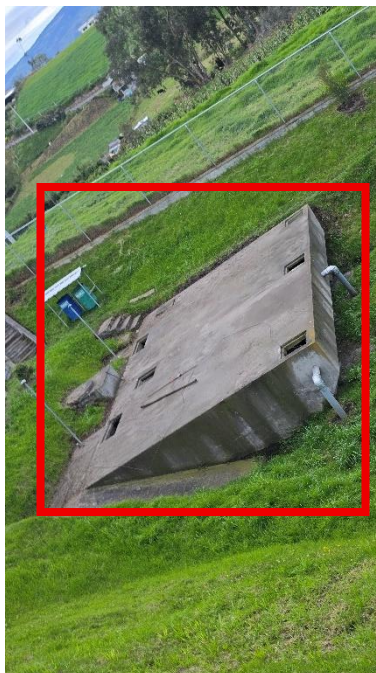
Fig. 32 Reactor Anaeróbico de Flujo Ascendente en Manto de Lodos
