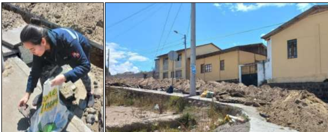
Fig. 16 Extracción del pavimento asfáltico reciclado (RAP)
