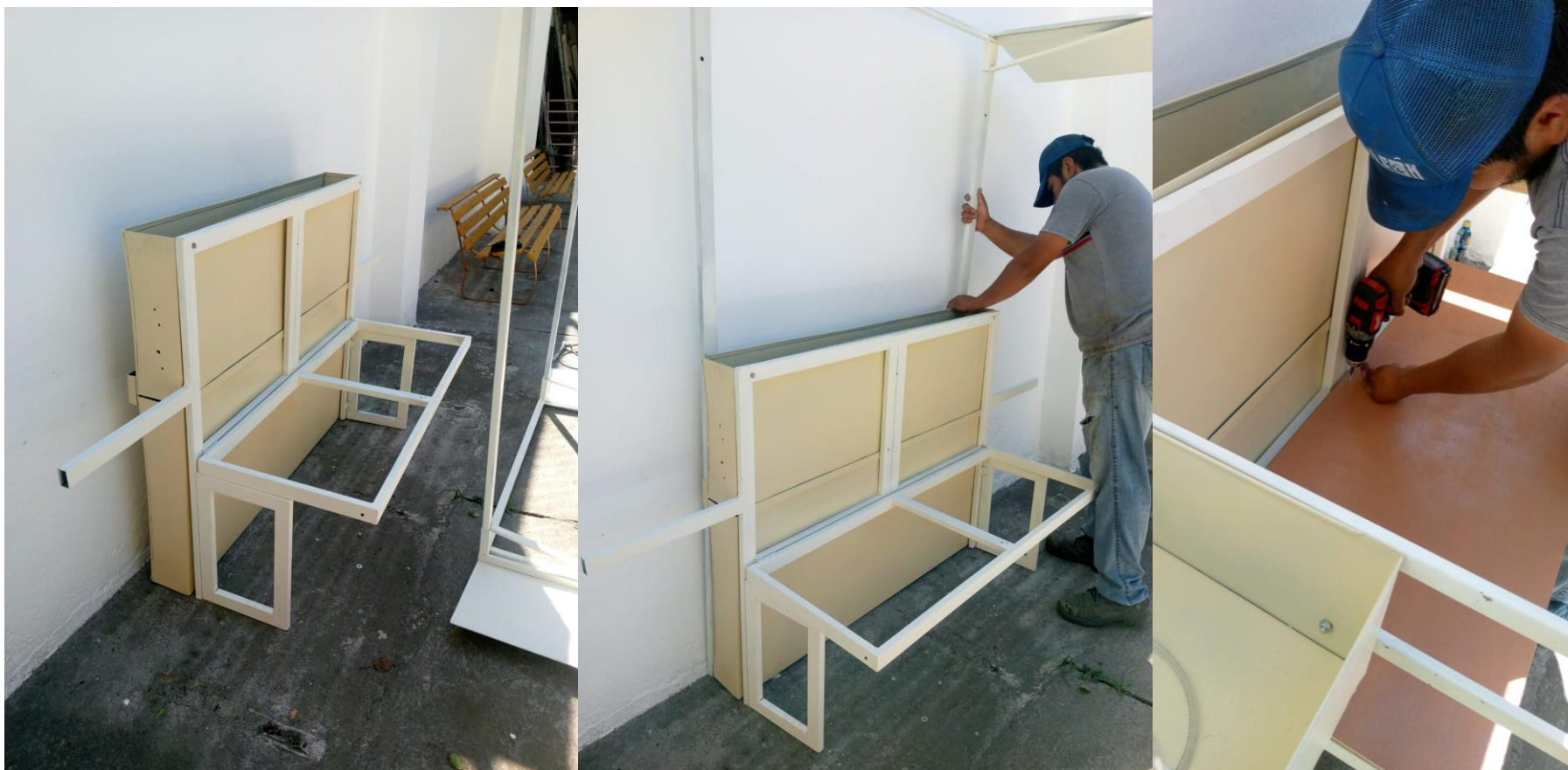
Figura 95. Proceso de instalación. Fotografías propias
