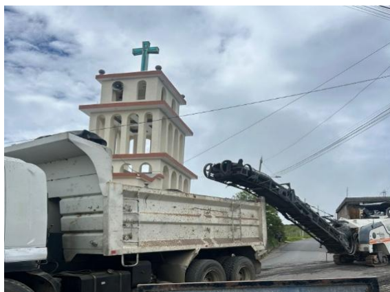
Fig. 2. Maquinaria para proceso de fresado de la Vía Jaloa-El Guasmo.
