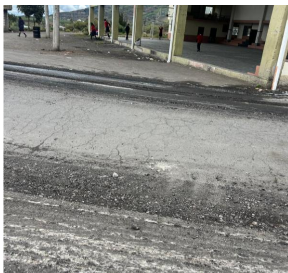
Fig. 3. Estado de la vía en el proceso de fresado.
