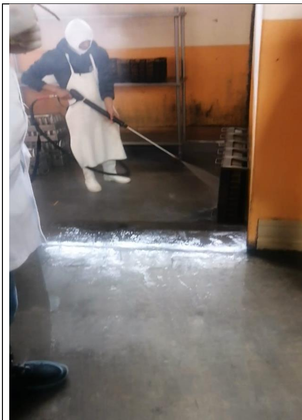
Paredes y piso forman esquinas. Paredes sin pintura lavable.
