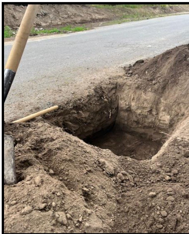
Fig. 6 Excavación de la calicata
