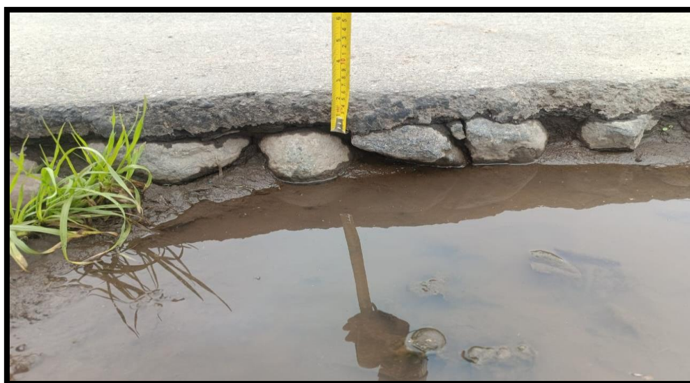
Fig. 7 Medición de los espesores que conforman la capa de rodadura actual.
