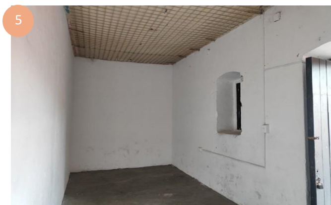
Imagen 7. Estado actual de las celdas rehabilitadas. Autoría propia (2026).
