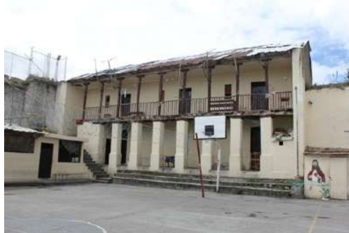
Descripción:Vista parcial del patio interior, el cual precede a los ambientes distribuidos ortogonalmente.
