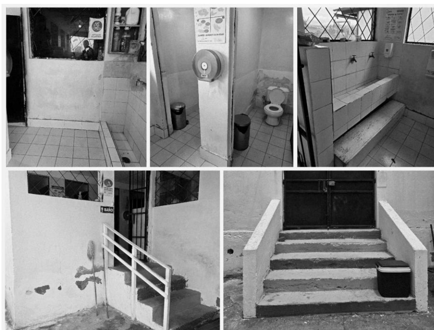
Figura 4. Distribución y estado actual de los servicios sanitarios, lavamanos e ingreso principal al área de baños del CDI San Jacinto de Izamba (Elaboración propia, 2025).
