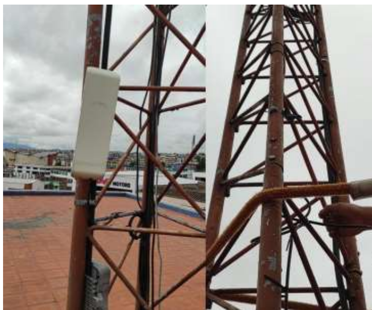
Figura 41. Instalación del CPE
