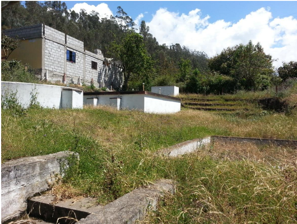
Gráfico #01 Tanques de oxidación en condiciones actuales
