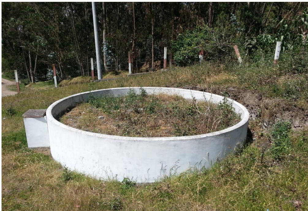
Gráfico #02 Tanques de oxidación en condiciones actuales
