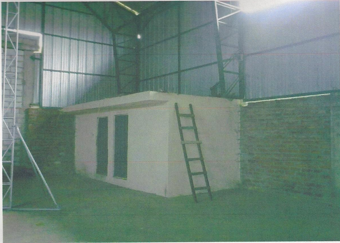
Baños y vestidores existentes
