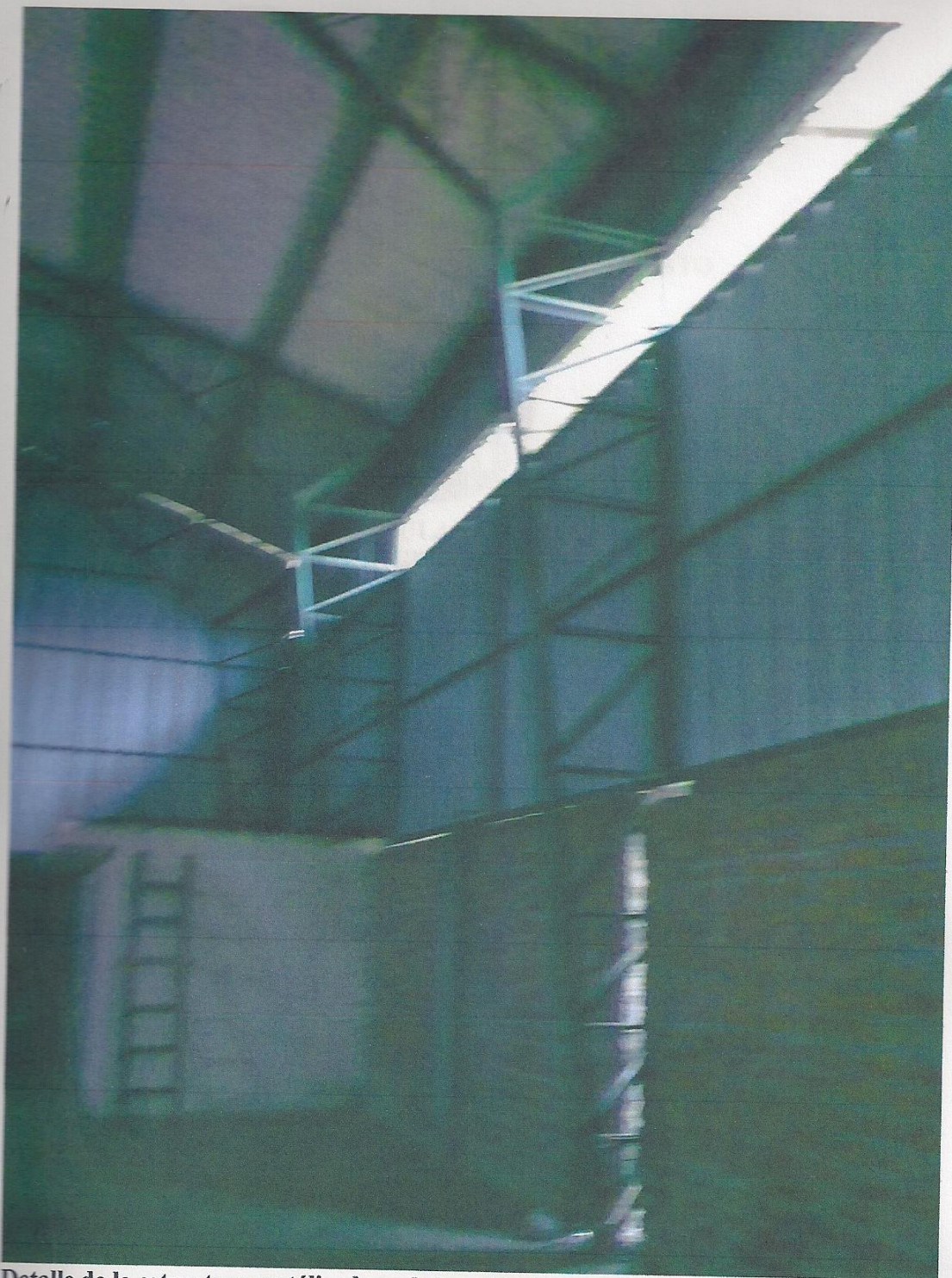
Detalle de la estructura metálica base de la cubierta
