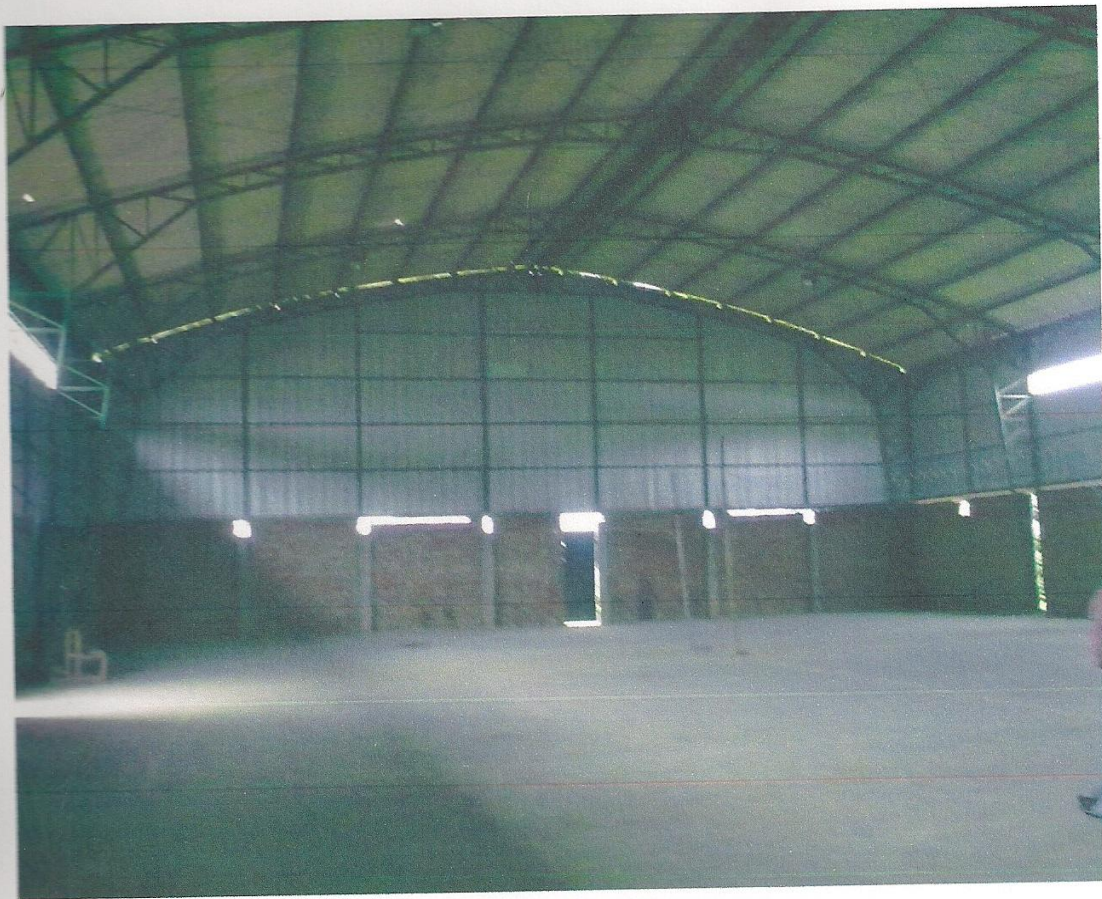
Estado de interior del coliseo con cerramiento provisional
