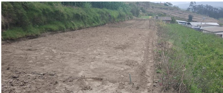
Fotografía 1. Preparación del terreno
