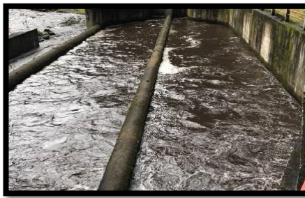
Figura 3 Agua que ingresa al canal Huachi-Pelileo en la época lluviosa
