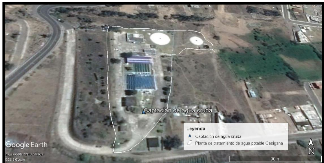
Figura 1 Localización de la Planta de tratamiento de agua potable Casigana Fuente: Google Earth, (s. f.).
