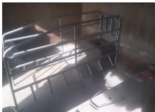
Adecuación e instalaciones de jaulas para cerdas
