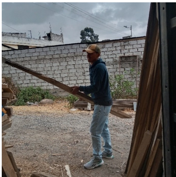
4. Bodega de almacenamiento de madera
