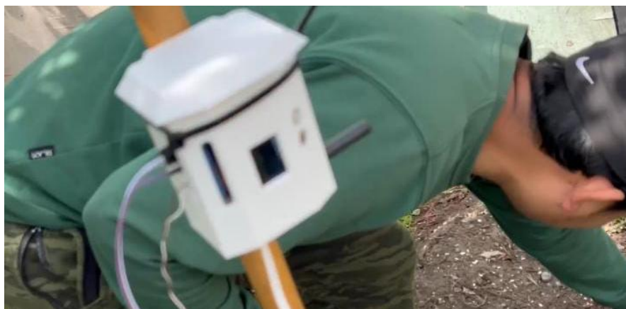
Figura F2. Instalación del case del módulo LilyGo LoRa32
