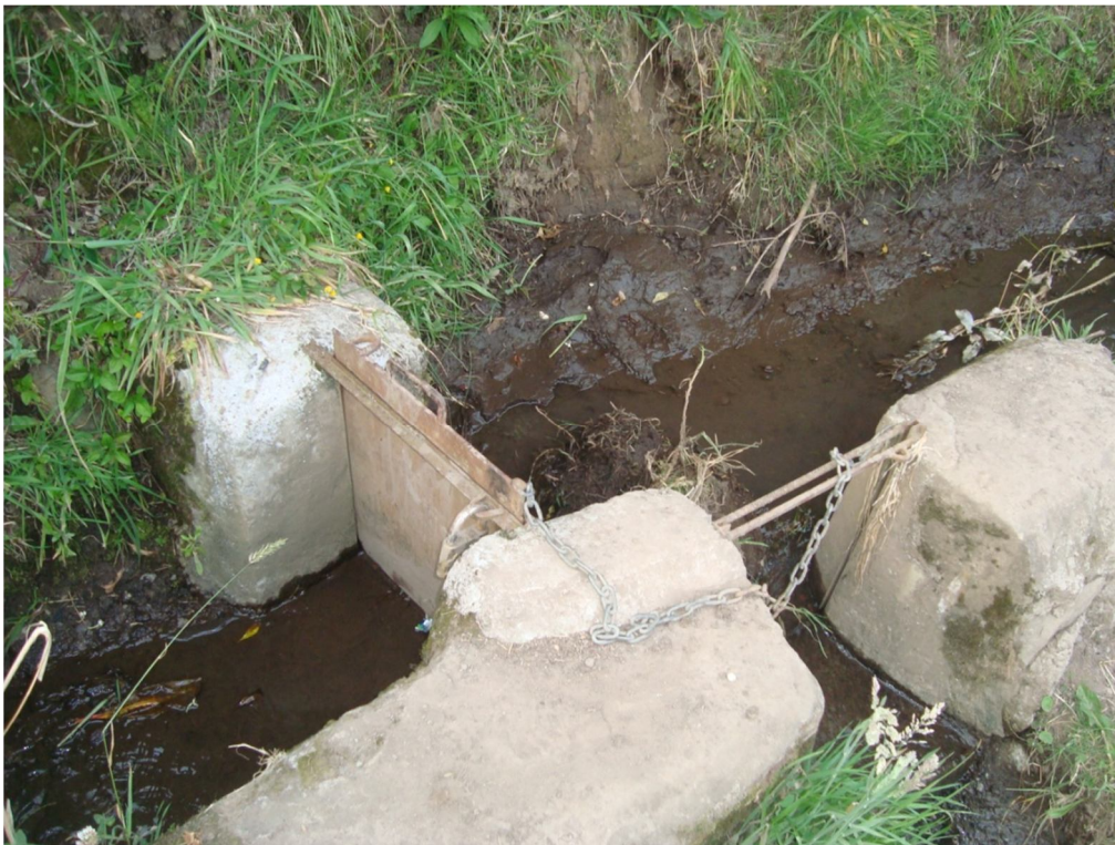
UBICACIÓN DE INICIO DEL SIFON O TANQUE DE INGRESO
