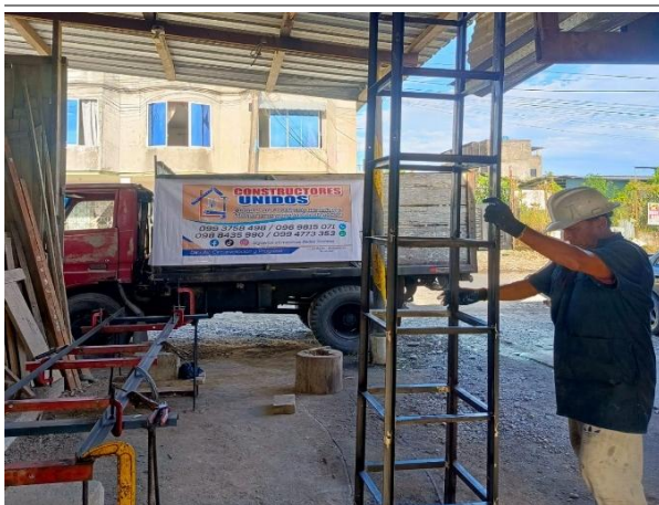
Armado de la estructura metálica (escalerilla)
