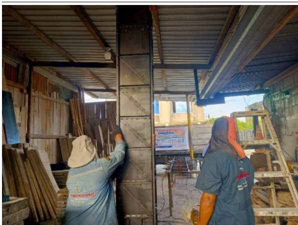
Columna metálica de 25x25
