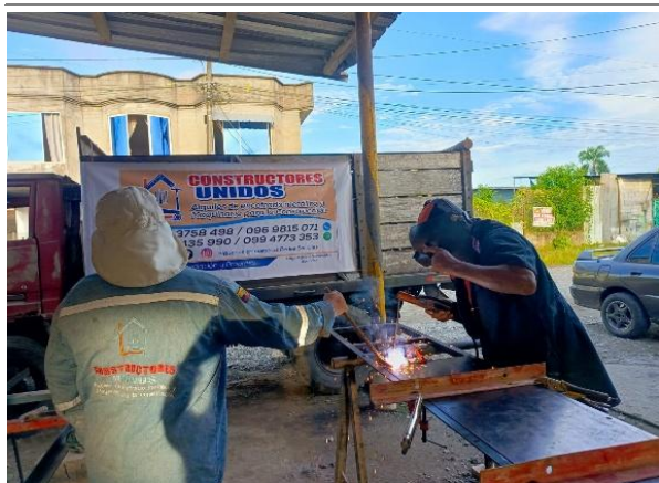
Soldadura de la plancha a la estructura metálica
