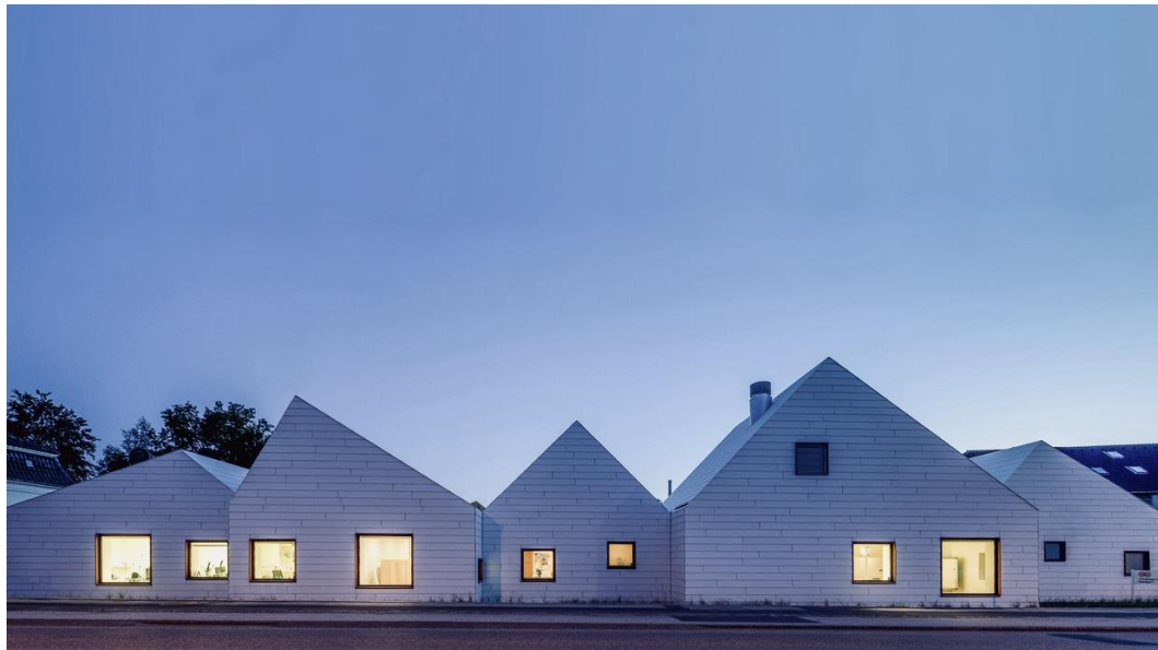
Figura 40. Vista exterior de Livsrup (Lake, 2013).
