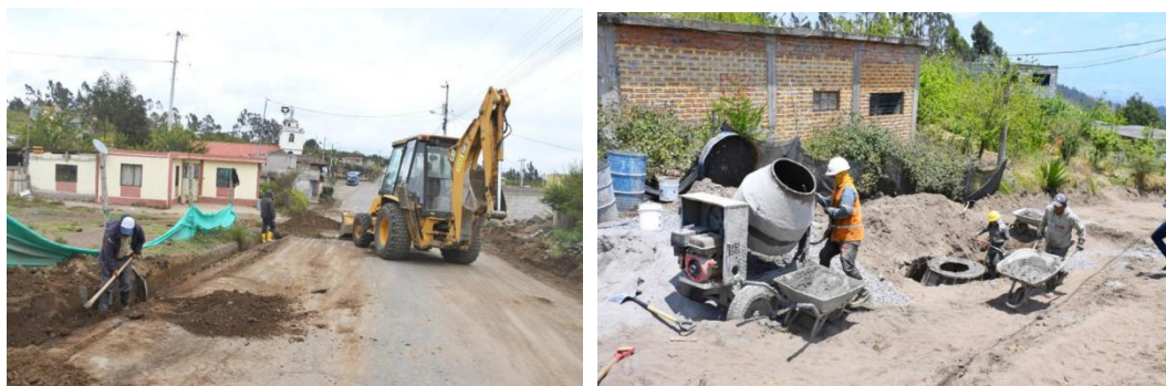
Figura 50. Construcción de alcantarillado sanitario en la parroquia Santa Rosa. Fotografía: EMAPA Ambato (2022).
