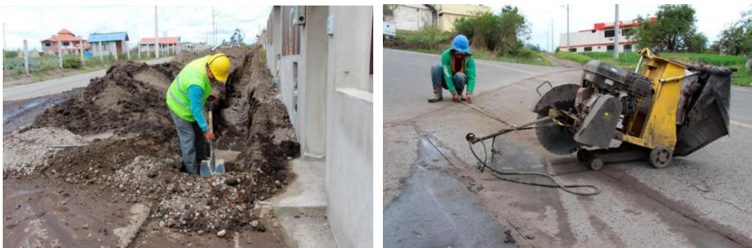
Figura 48. Trabajos de instalación de la red de agua potable en Santa Rosa. Fotografía: EMAPA (2017)
