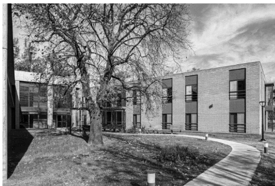
Imagen 8. Vista de jardines y espacios exteriores del Centro Sentidos.
