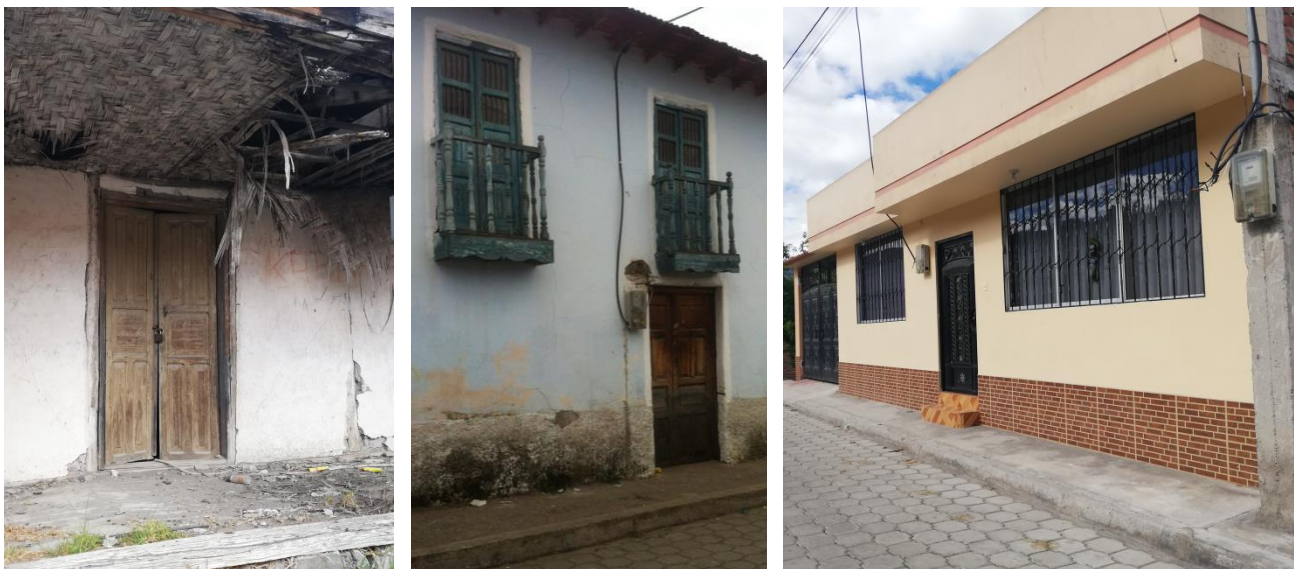
Imagen 82: Viviendas antiguas y nuevas, parroquia Licto
