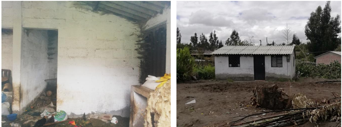
Imagen 79: Viviendas abandonadas, ubicadas en el sector Langos San Alfonso, cantón Guano.
