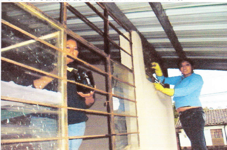
FOTO 6. Lijada y pintada de la estructura metálica
