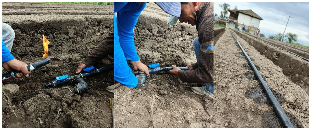
Ilustración 4. Instalación del sistema de riego
