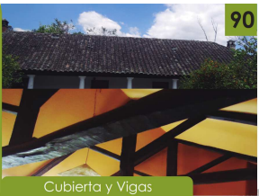
Cubierta y Vigas Créditos: Janeth Mármol
