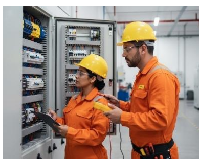
Figura 32. Inspección del tablero
