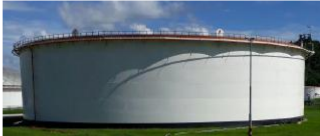
Figura 4. Tanque de techo fijo
