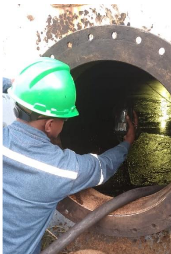
Figura 19. Medición de gases en espacio confinado
