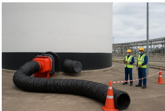
Figura 26. Desgasificación y ventilación
