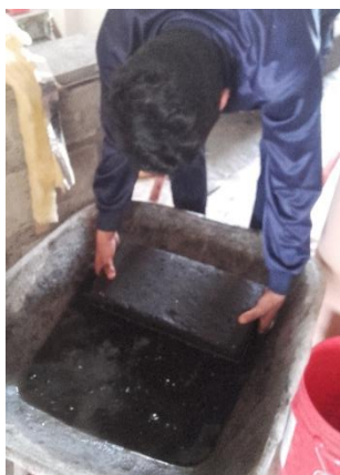
Humedecimiento de los bloques antes de ser colocados.
