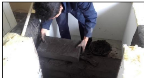
IMAGEN 18: Elaboración del panel de adobe
