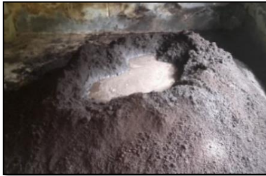
IMAGEN 12: Mezclado de la tierra cruda
