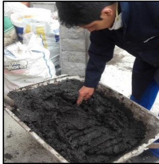
IMAGEN 17: Preparación del mortero para realizar los muros de adobe
