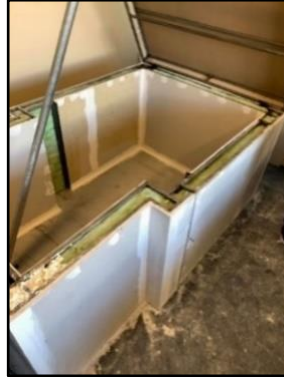
IMAGEN 5: Ensamblado de la cámara hermética
