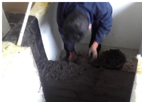
Fabricación de los paneles de adobe.
