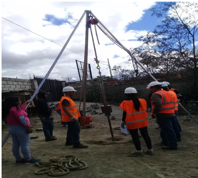
Fotografía 2 Hincado del martinete
